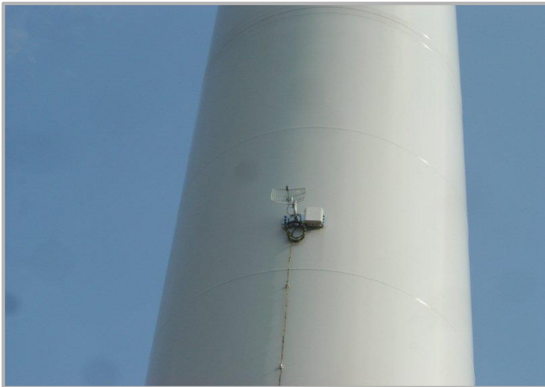
Rysunek 2. Antena radiolinii zamontowana na wieży wiatraka
